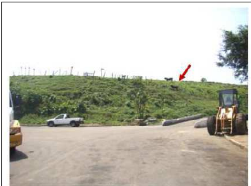
Figura 4.8.1-3 - Cercamento do terreno do antigo lixão
