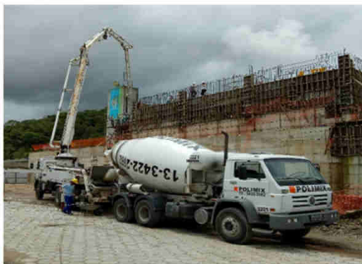
Concretagem das paredes dos floculadores – Unidade de Processo
