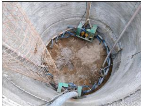
EEE PR1 – Poço de sucção executado com concreto projetado
