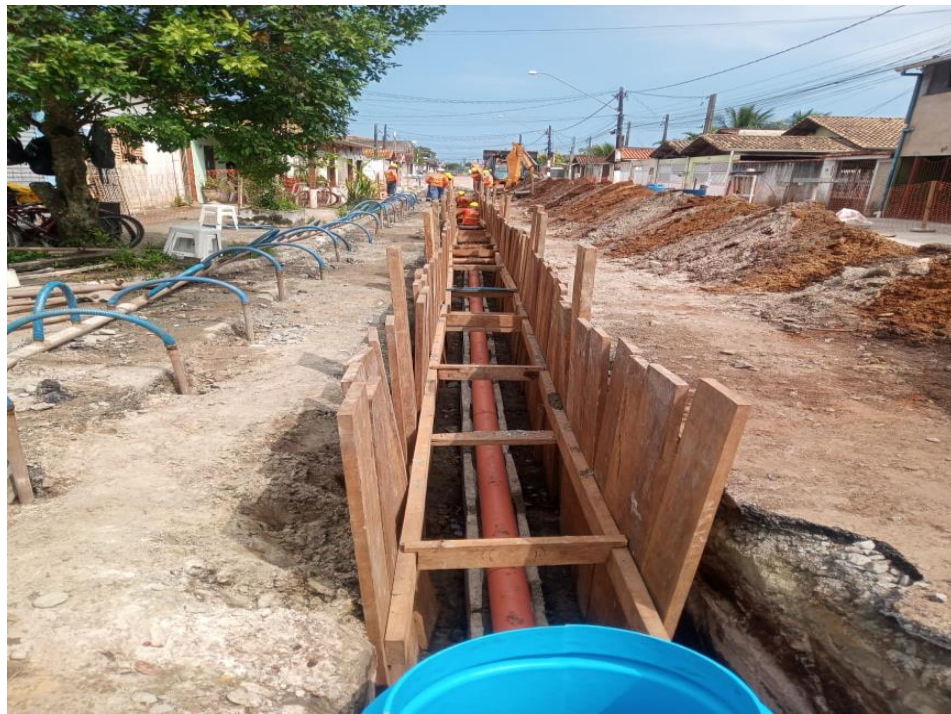
SES Trevo/Melvi – Assentamento de Tubulação PVC_DN150mm - Rede_Coletora SB 01 02 – R Antônio Cunha Bueno
