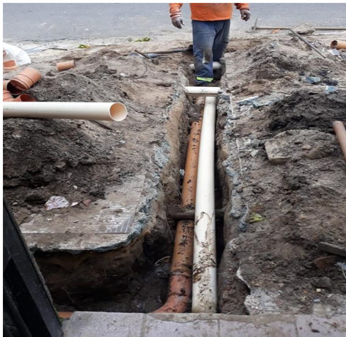
SES Sítio do Campo – execução de ligação domiciliares de esgoto – conexão posterior – Rua João Mendes Júnior
