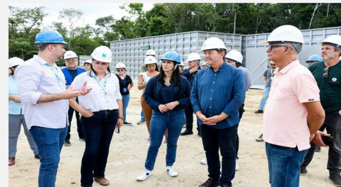
Secretária de Meio Ambiente, Infraestrutura e Logística visitou a Baixada Santista para acompanhar as obras. Foto: Divulgação/Governo de SP
