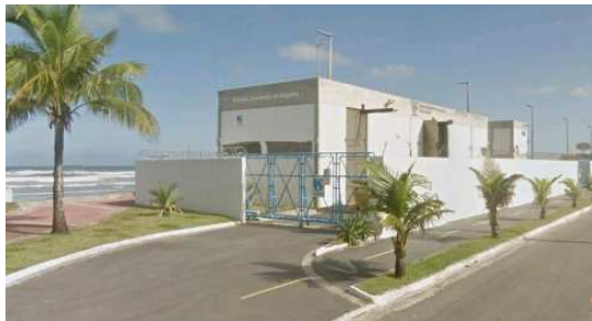
Estação Elevatória de Esgotos do subsistema III, no bairro Real (Avenida Presidente Castelo Branco) Fonte: Google Street View, 2012
