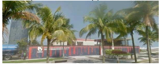
Estação de Pré Condicionamento/ Estação Elevatória de Esgotos do subsistema II, no bairro Tupi (Avenida Presidente Castelo Branco)
