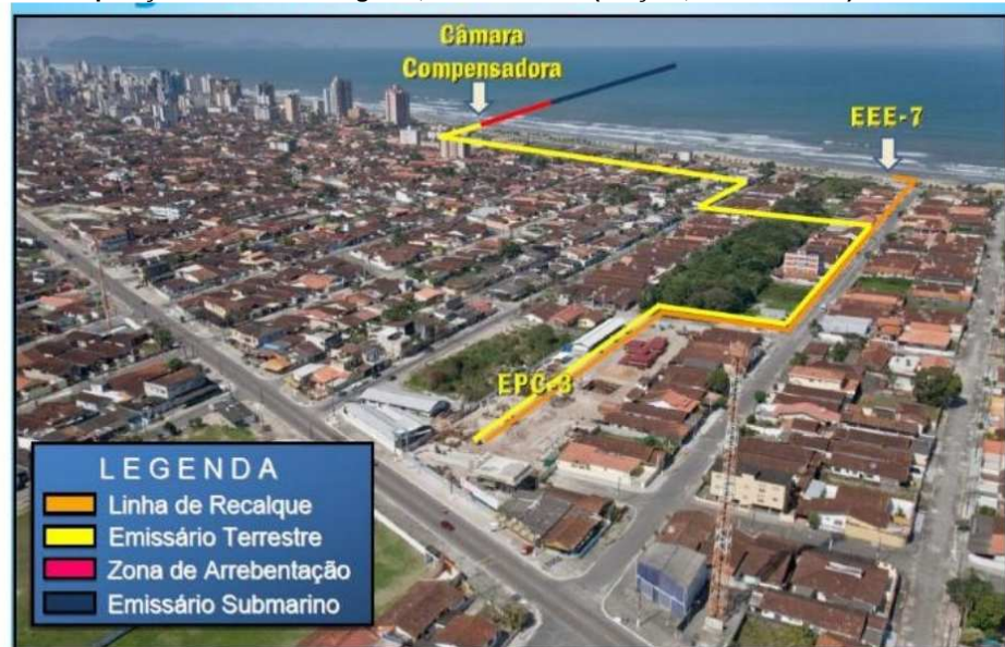
Figura 11 - Sistema de disposição oceânica de esgotos, subsistema III (Caiçara, no bairro Real)
